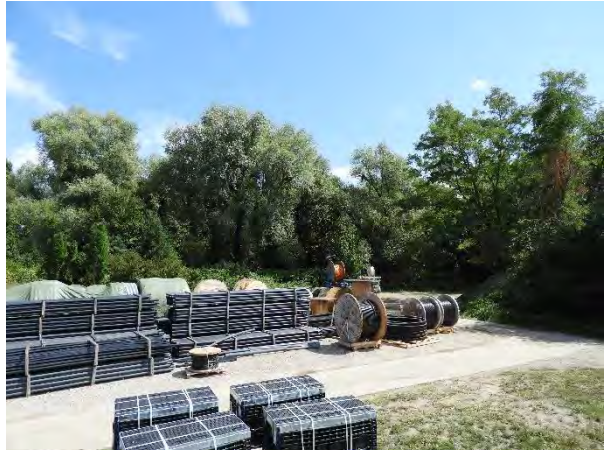
Lagerflächen, teils befestigt, teils Schotterterrassen
